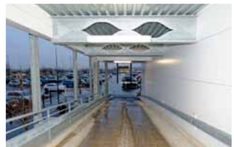
Fig. 2: Angelina™-liggers voor de gelijkvloerse verdieping Fig. 2: Poutres Angelina™ pour le rez-de-chaussée
