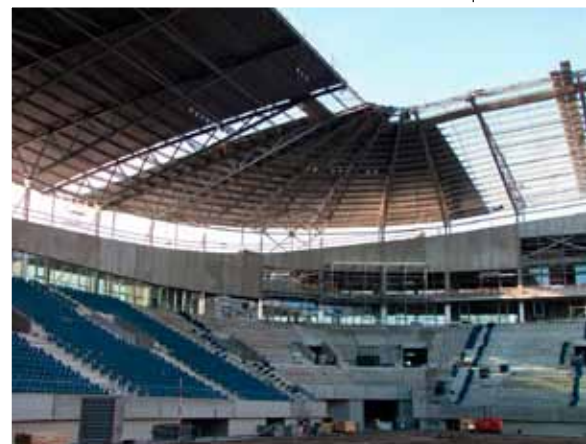
Geprofileerde aluminiumplaten bekleden de luifel _Tôles d'aluminium profilées comme revêtement de l'auvent
